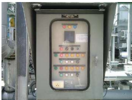
ภาพที่ 2.2-10 ระบบตรวจวัดน้ำทิ้งแบบอัตโนมัติ
