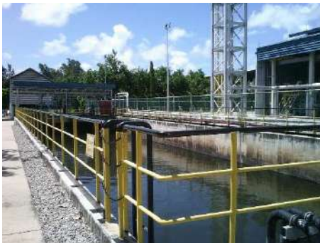
ภาพที่ 2.2-8 บ่อพักน้ำทั้งหมด 1,600 ลูกบาศก์เมตร
