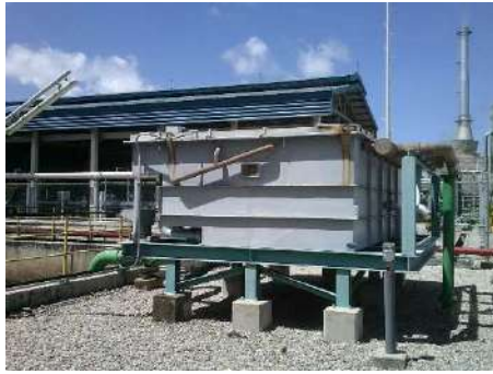
ภาพที่ 2.2-6 ถังแยกน้ำกับน้ำมัน
